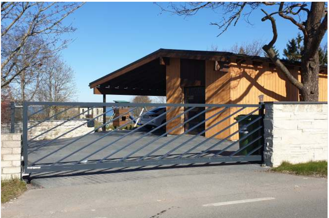
Kaldvarbiga liugvärav alumiiniumist Ka siin aitas materjali kergus elegantsele lahendusele kaasa.
