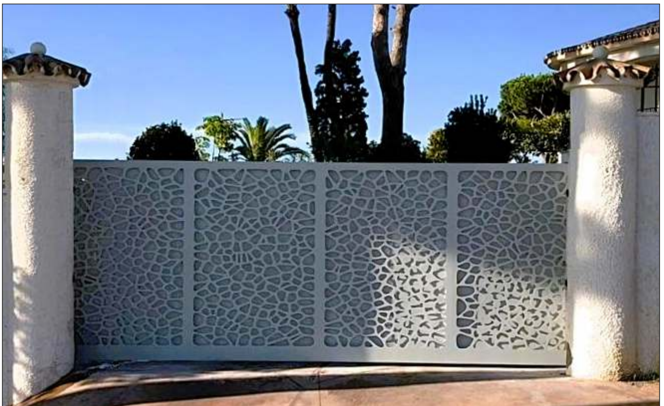
Liugvärav Marbellas soolase mere ääres Alumiiniumi korrosioonikindlus on sellistes piirkondades selge eelis
