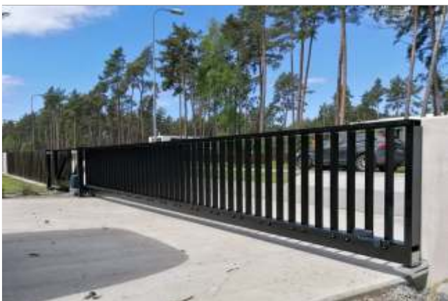
Alumiinium võimaldab kasutada jämedamast materjalist täidist ilma, et värav ära ei vajuks.
