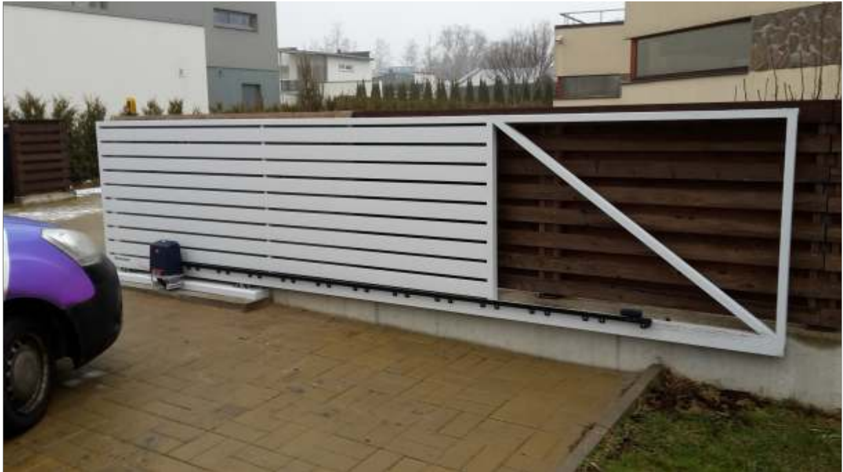
Alumiiniumlaudisega värav. Kuna alumiinium ei mädane, siis on see värav praktiliselt hooldevaba. Piisab vaid aeg-ajalt survepesuri kasutamisest.
