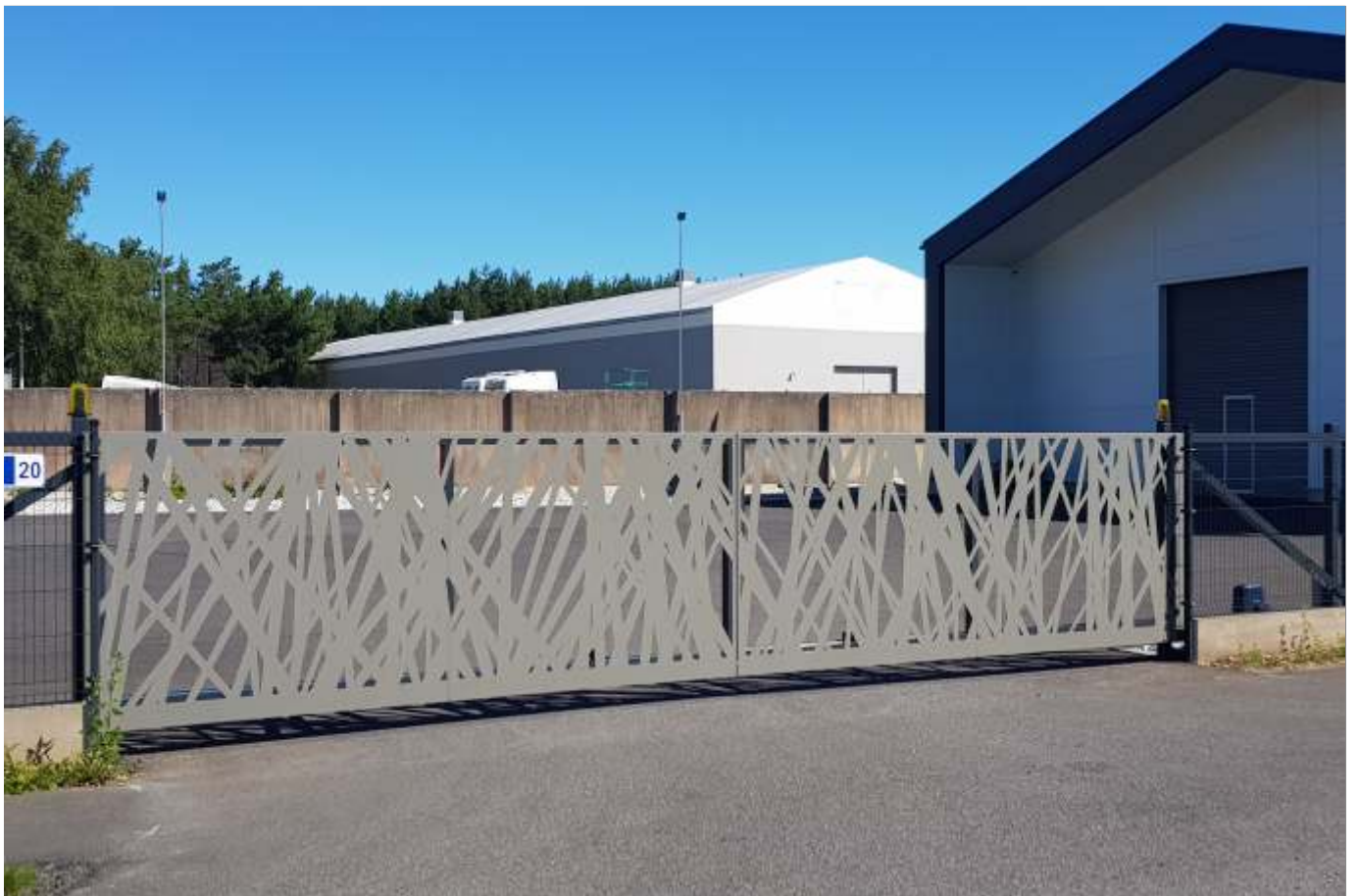
Ka tööstuslik liugvärav võiks olla ilus ja funktsionaalne. See kahepoolne 8m liugvärav avaneb ~15 sekundiga.
