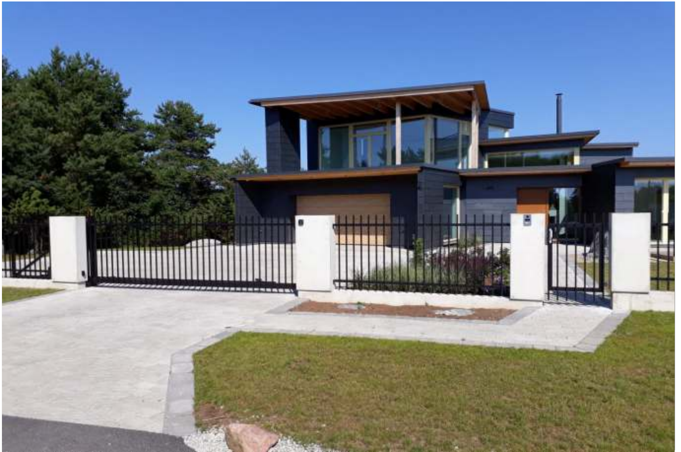
Eramu Viimsis. Varbtäidisega aed, liugvärav ja jalgvärav. Garaažiuks hele tamm. Kõik juhitavad ühest puldist.
