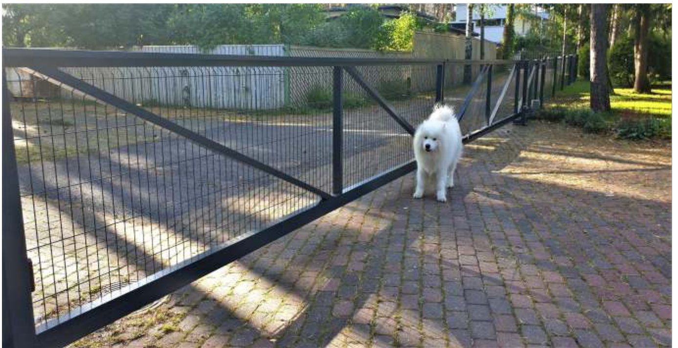
Kahepoolne võrktäidisega liugvärav 10 m avale. Kitsas tänav nõuab laia väravat. Ühtlasi annab võrk piisavalt vaadet lemmikloomale.
